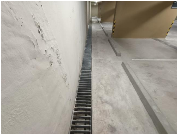
รูปที่ 2-35 จัดให้ชั้นใต้ดินที่ 3-5 มีท่อระบายน้ำเพื่อรวบรวมน้ำฝนไปยังบ่อสูบน้ำ
