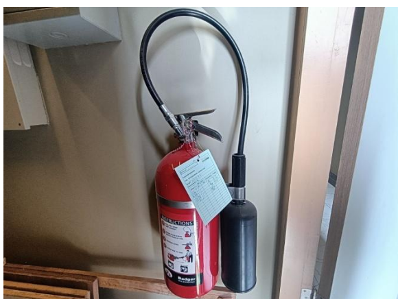
ถังดับเพลิงชนิดมือถือและคำแนะนำการใช้
