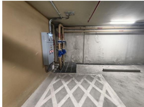
รูปที่ 2-35 จัดให้ชั้นใต้ดินที่ 3-5 มีท่อระบายน้ำเพื่อรวบรวมน้ำฝนไปยังบ่อสูบน้ำ
